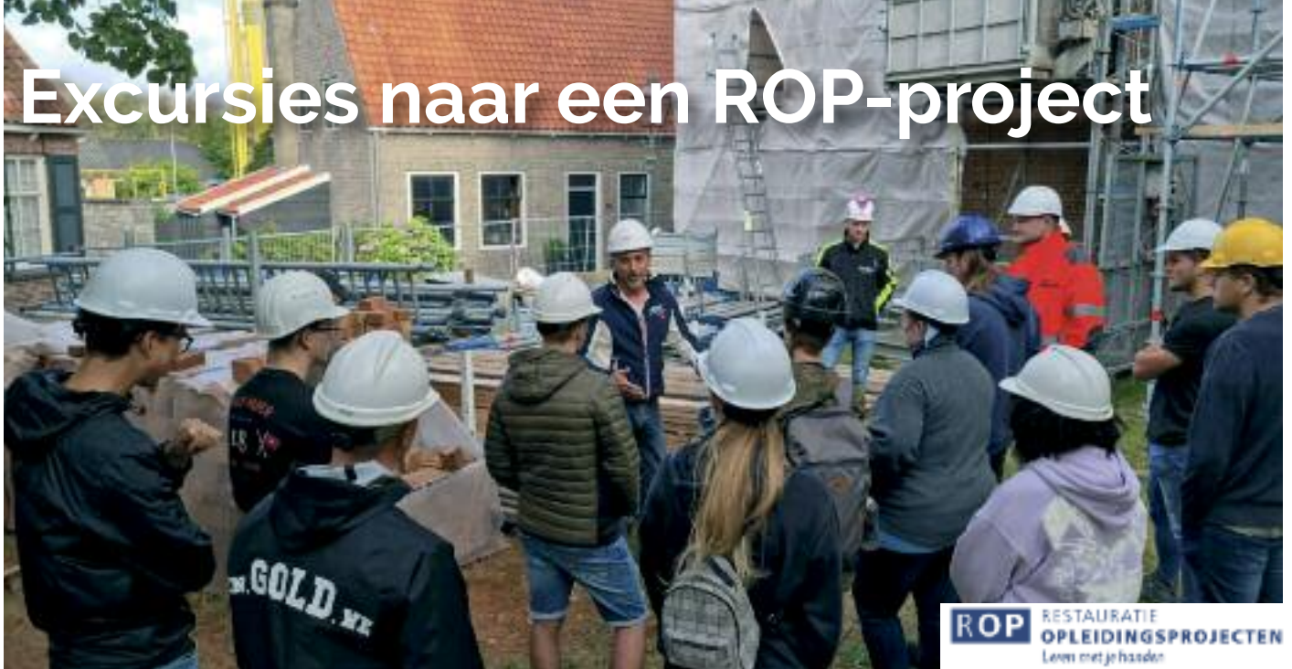
Afbeelding Rondleiding van mbo-leerlingen bij een ROP-project.
