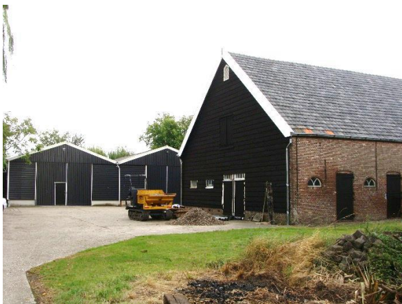
Op het erf van Josine Boonman in Nisse is om de aardappelcel een op de erfbebouwing afgestemde dubbele damwandloods geplaatst (foto Provincie Zeeland).
