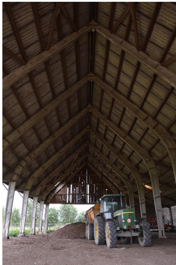
De naoorlogse kapschuur met asbest dakbedekking van Carlos de Dobbelaere in IJzendijke is in hoge mate authentiek. Een volwaardige bestemming is nog niet gevonden, waardoor volledige sanering dreigt.
