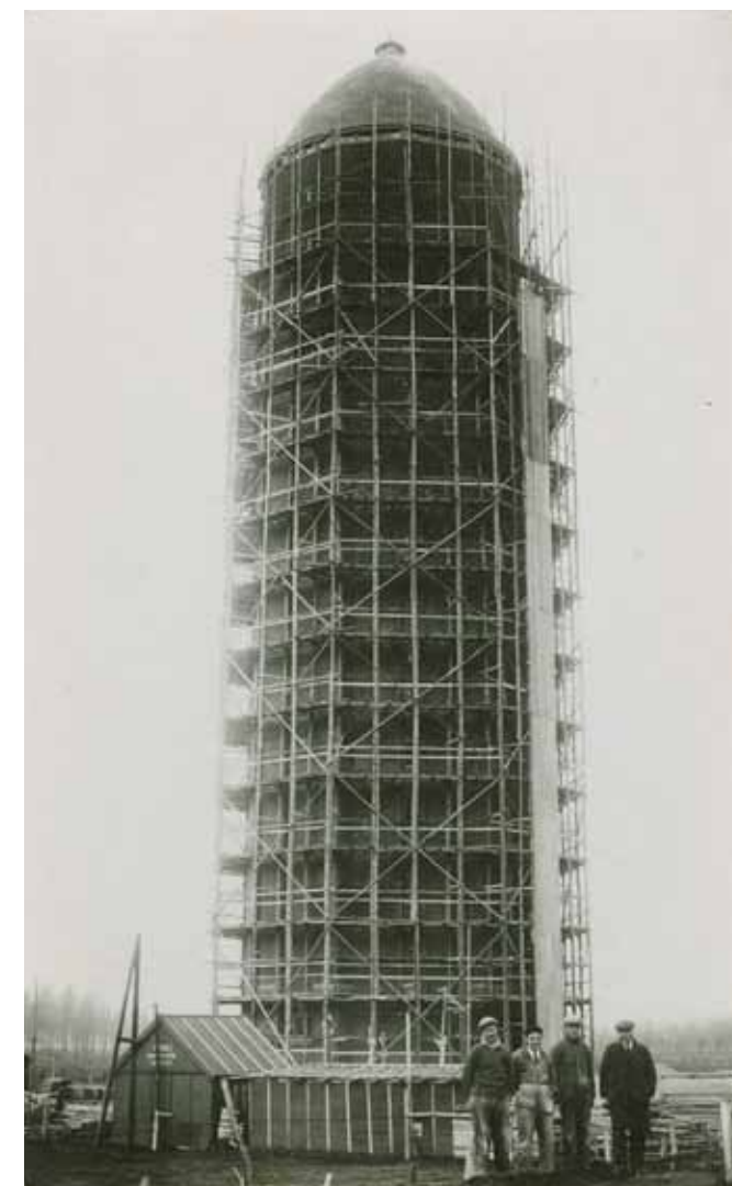
↑ De bouw van de watertoren aan de Kinderdijk te Axel in 1936 | Zeeuws Archief, Fotoarchief (voormalige) gemeente Axel, nr. 836.
