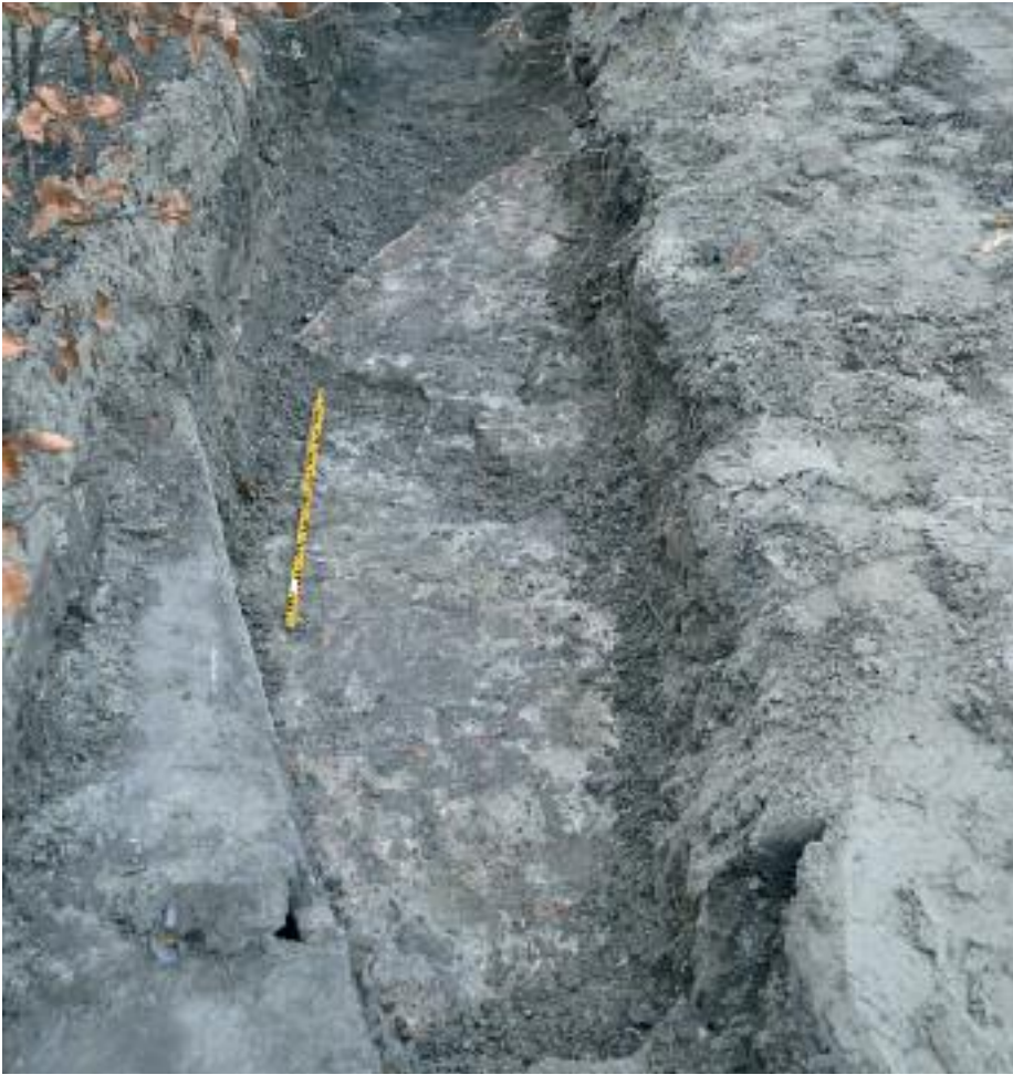
Afbeelding Zware fundering in een sleuf in de achtertuin van Singelstraat 7 in Goes.
