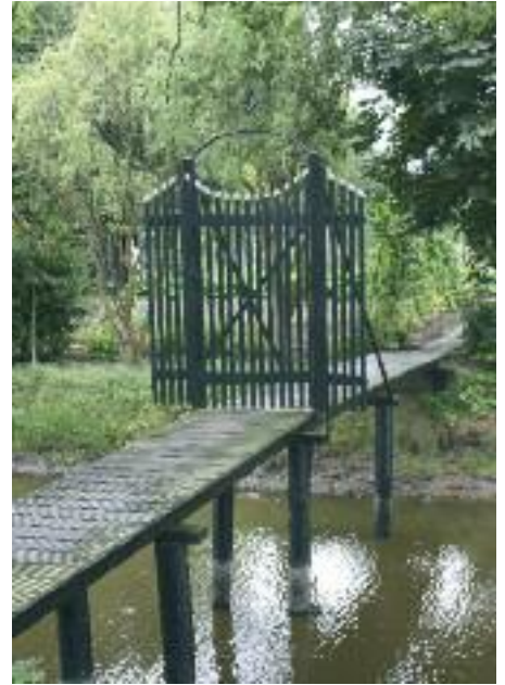
De brug met houten hekwerk over de gracht naar de hof is tien jaar geleden in oude glorie hersteld.
