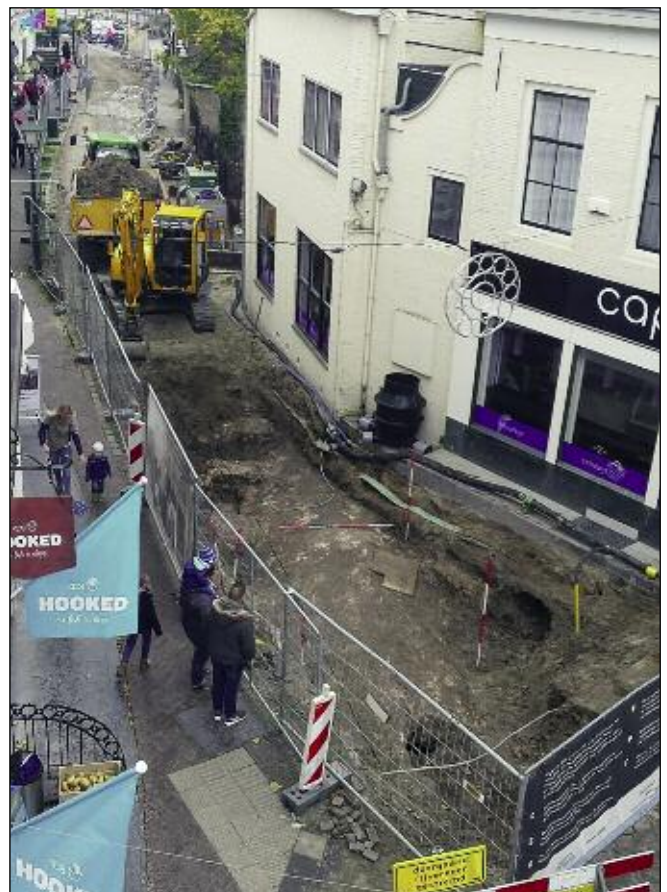
Overzicht rioleringswerkzaamheden in de Mol te Zierikzee, met resten van een groot gewelf (foto M. van der Zande).
