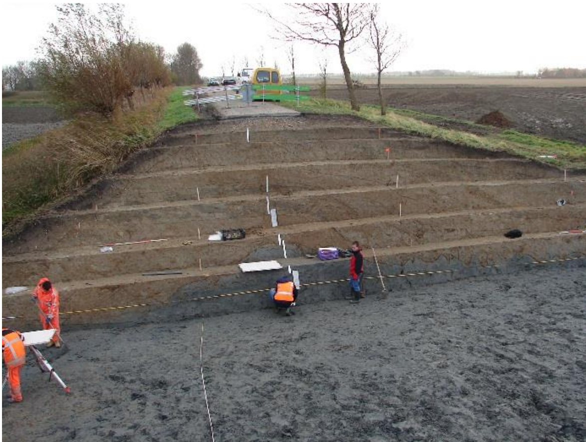
Wissenkerke-Emelissedijk. Dwarsdoorsnede door de in 1598 aangelegde en tot 1616 verbeterde Emelissedijk. Dit onderzoek mag als voorbeeld gelden voor toekomstig dijkonderzoek in Zeeland. Foto SCEZ, Middelburg.
