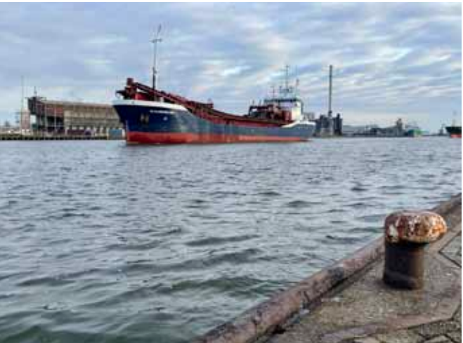
↑ Het kanaal ter hoogte van Sluiskil | foto David Koren.
