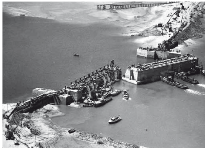
↑ Afsluiting van de Braakman met caissons, 1952 | Rijkswaterstaat, Afdeling Multimedia.
