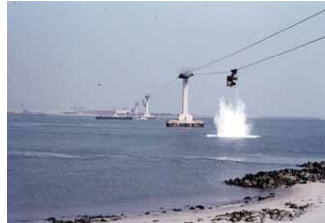
↑ Een kabelbaan stort betonblokken voor de aanleg van de Brouwersdam, 1971 | Zeeuws Archief, Beeldbank Schouwen-Duiveland, nr. BRW-0433.
