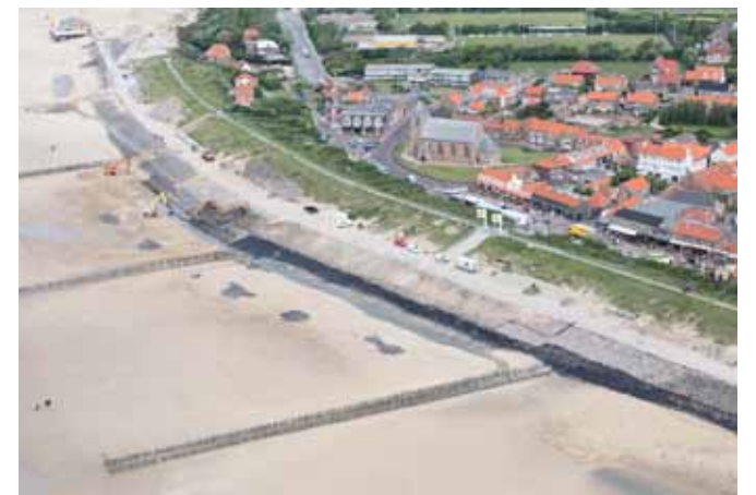
↑ Werken aan de dijk voor Zoutelande, 2009 | foto Joop van Houdt, Rijkswaterstaat.
