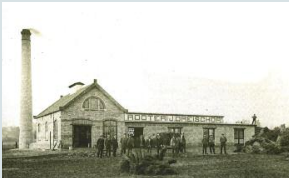
'Rooterij Dreischor', gebouwd in 1920, waar het vlasroten in vier betonnen bakken, inhoud 30 m 3 , met warm water gebeurde | bron: Stad & Lande , 2021, 1.
