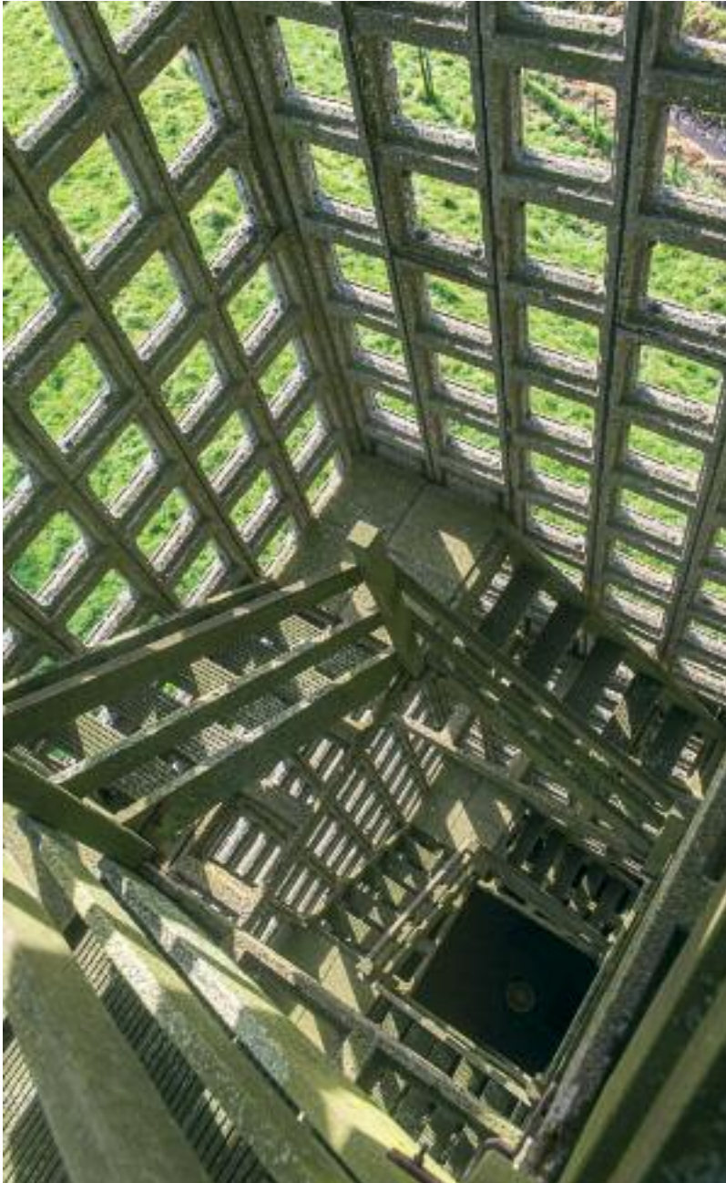
Afbeelding De betonnen raten en hardhouten trappen van de luchtwattoren in Nieuw-Namen | portret- en detailfoto Mieke Wijnen Fotografie.
