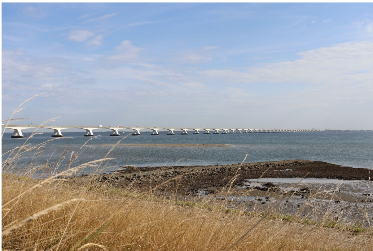
Zeelandbrug vanaf Oostzeedijk Kats, foto: Gemeente Noord-Beveland
