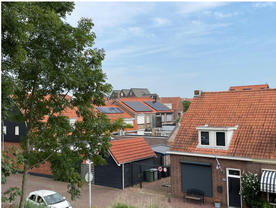
Afbeelding 31: Egale zonnepanelen (midden rechts) vallen minder op dan panelen met randen (midden links).
