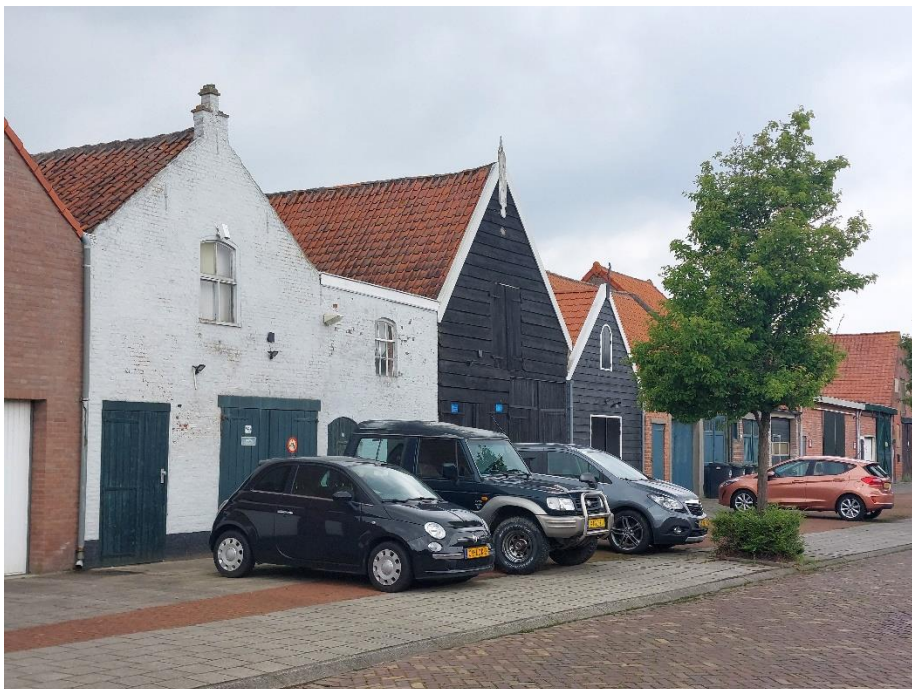
Afbeelding 24: Schuren met zadeldaken (dwarskappen). De voorste stukken van de zijdakvlakken zijn zichtbaar vanaf de straat.
