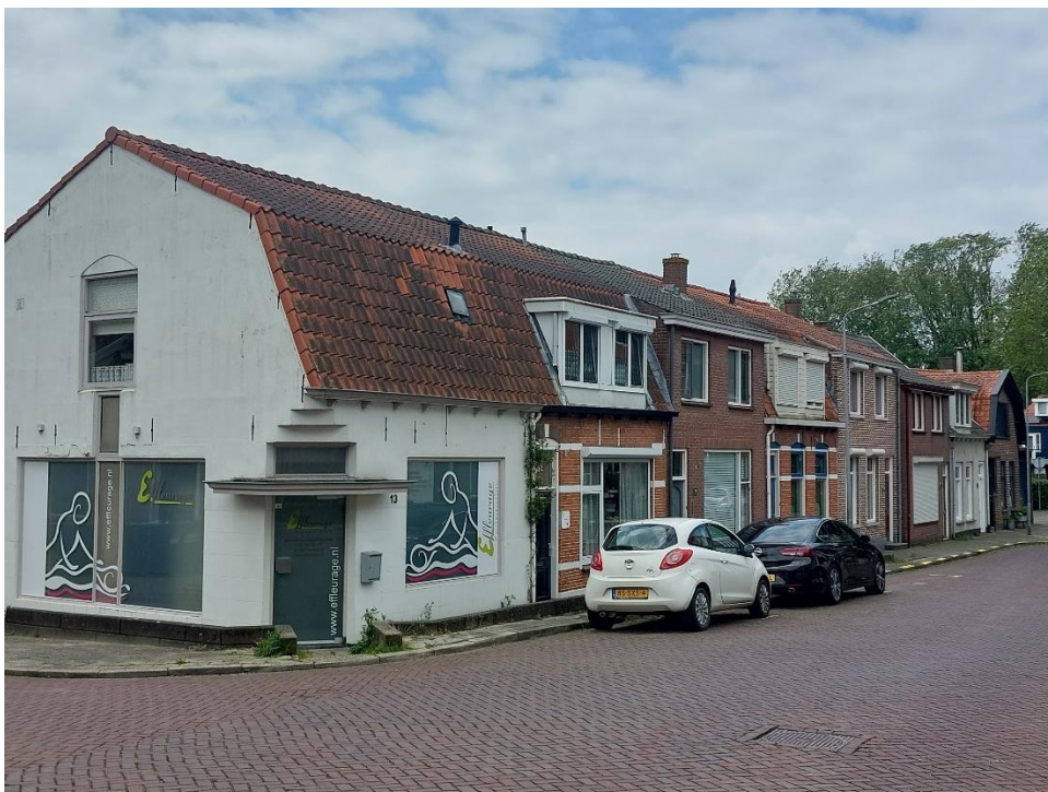
Afbeelding 28: Mansardekappen in de langsrichting ten opzichte van de straat. Doordat de woningen relatief laag zijn, zijn zowel de boven- als onderkant van het voordakvlak goed zichtbaar.
