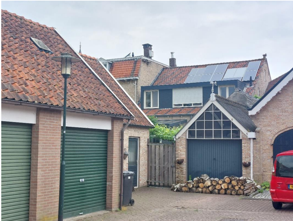
Afbeelding 30: De dicht op de dakranden geplaatste zonnepanelen van verschillende grootte, zorgen voor een lage beeldkwaliteit.
