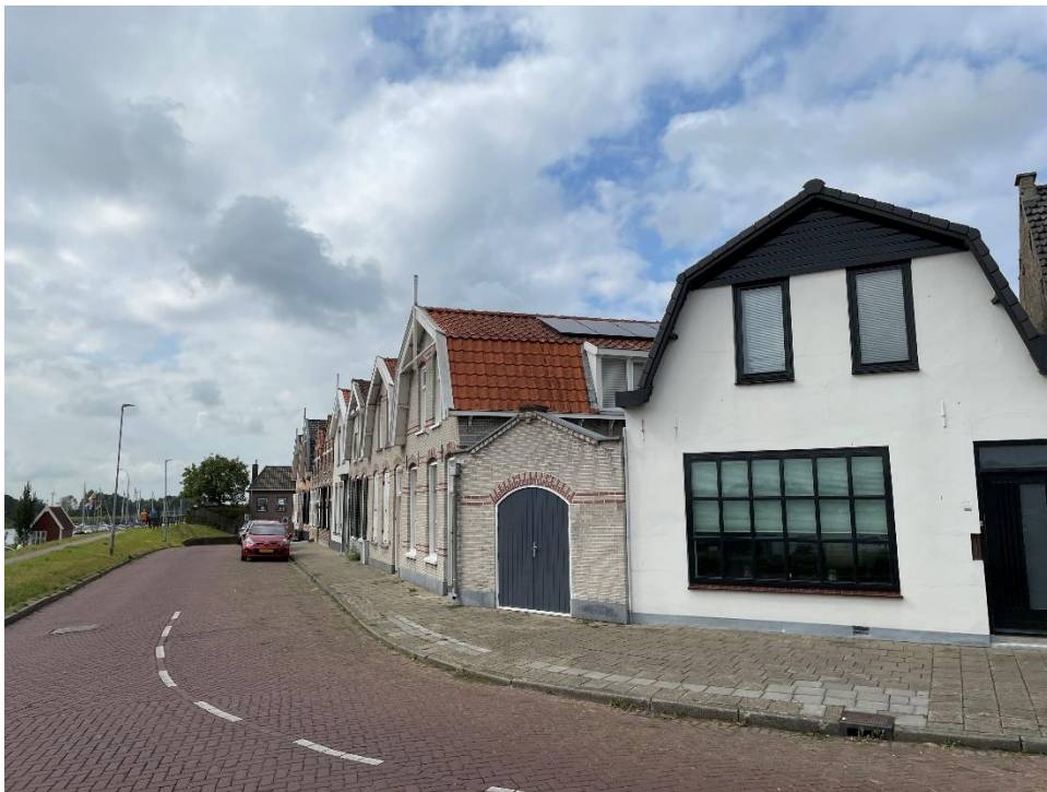
Afbeelding 27: Mansardekappen in de dwarsrichting ten opzichte van de straat met zonnepanelen op het bovenste helft van het dakvlak.
